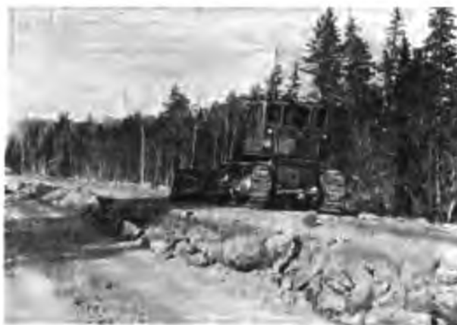
Рис. 3. Планировка насыпи бульдозером
