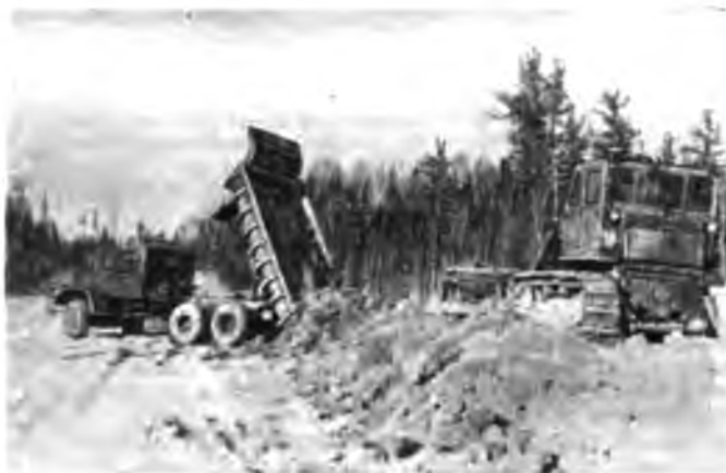
Рис. 1. Транспортировка грунта автосамосвалами и разравнивание слоев бульдозером
