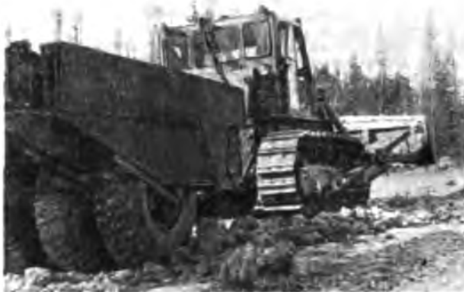
Рис. 2. Уплотнение слоев насыпи прицепными пневмокатками
