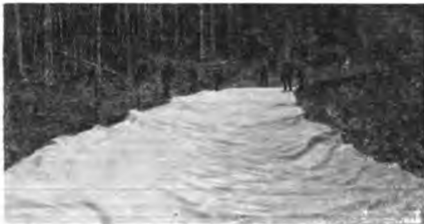
Укладка полимерного материала
