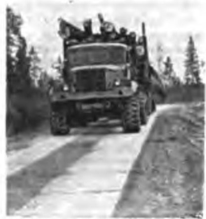
Опытный участок лесовозной дороги с покрытием из плит ПТ-3С
