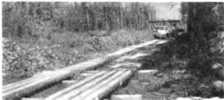
Рис. 1. Укладка дорожных щитов ЛВ-11 на временных автодорогах с помощью щитоукладчика ДУП-2М,
