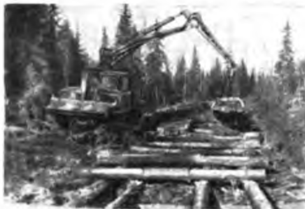
Рис. 2. Укладка дорожных щитов щитоукладчиком ЛД-17
