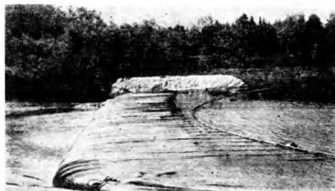
Рис. 4. Временная лесосплавная плотина запанного типа для подъема уровня воды и обсохшей древесины на реках
