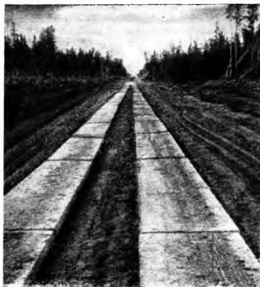
Рис. 3. Участок дороги, подготовленный к засыпке межколеиного основания
