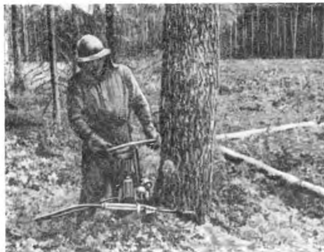
Спиливание дерева бензопилой с гидроклином
