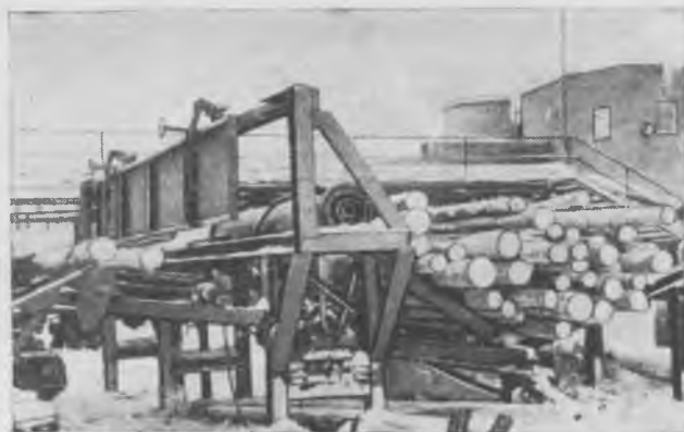
Рис. 1. Устройство для поштучной выдачи бревен
