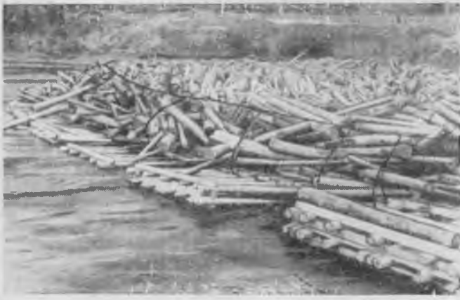
Рис. 1. Стерляжинская запань на р. Мане. На переднем плане видны плитки запани, погруженные в воду пыжом (над плитками — дополнительный лежень и тросовые связи)
