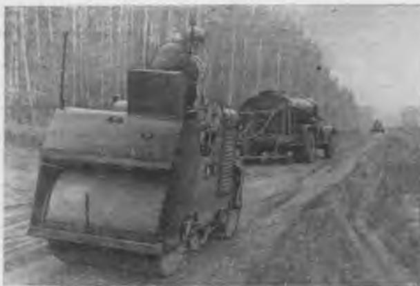
Рис. 2. Разравнивание, увлажнение и укатка смеси цементогрунта
