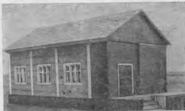
Рис. 2. Экспериментальное здание из деревобетона
