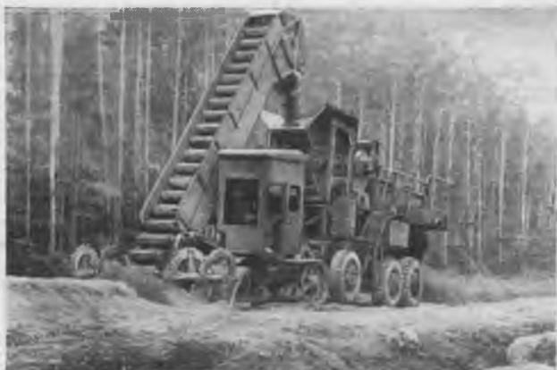
Рис. 1. Перемешивание грунта с цементом грунтосмесительной машиной Д-370
