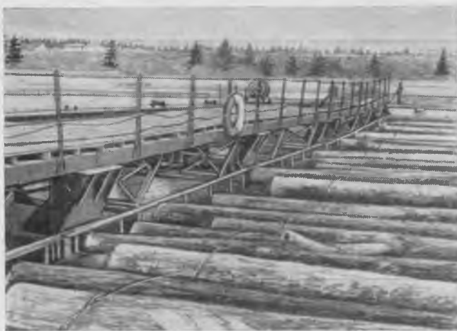
Набор линейки пучков в формировочной машине
