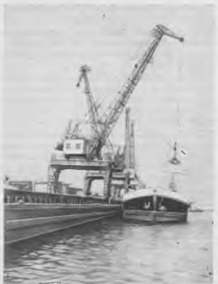
Рис. 3. Краны БКСМ-14 на выгрузке пиломатериалов
