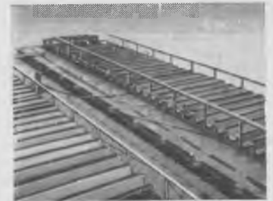
Рис. 3. Участок строящейся сортировочной установки
