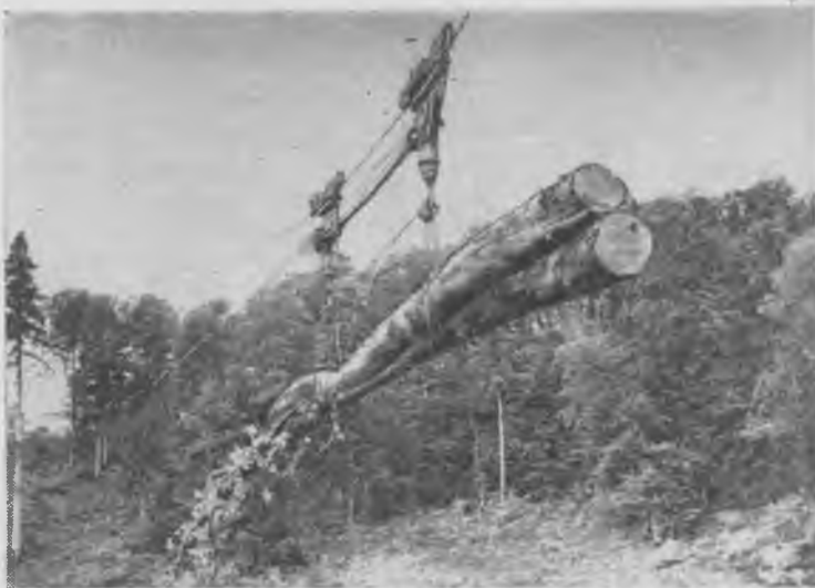
Рис. 3. Большегрузная канатная установка БКУ-8 в работе
