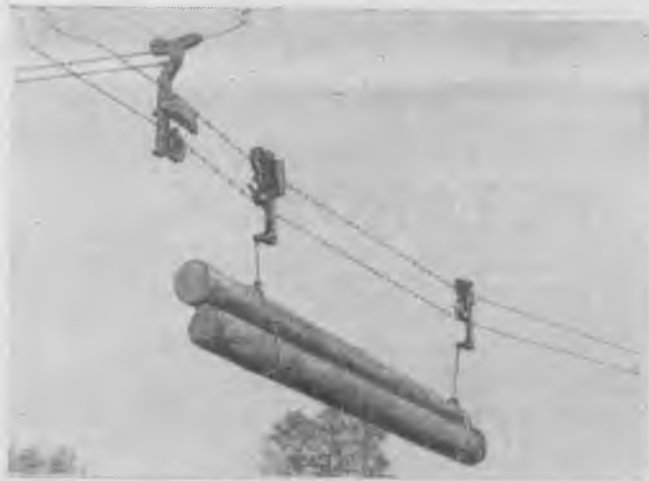
Рис. 2. Каретка с грузом у роликовой опоры
