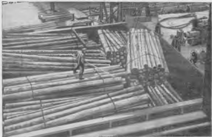
Рис. 3. Укладка пучков леса в трюме судна машиной ППМ-ВКФ
