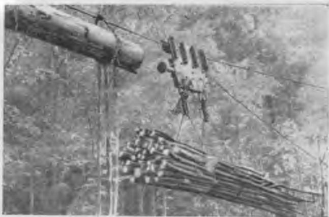
Рис. 2. Каретка Гошука с грузом и отбойное бревно у места разгрузки
