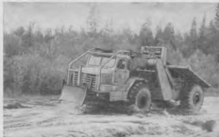
Рис. 1. Лесовозная машина МоАЗ-546Г-865 (фото И. Лесмана)
