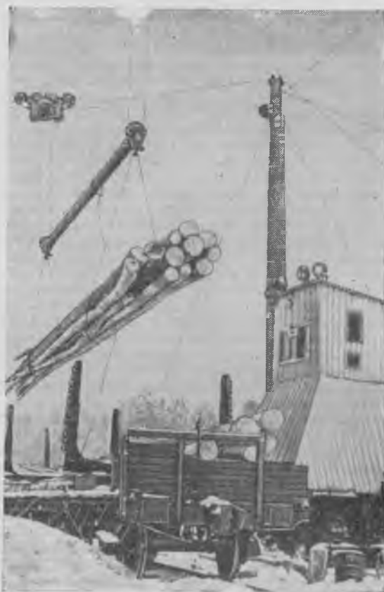
Рис. 1. Погрузка хлыстов на сцеп вагонов МПС кабель-краном
