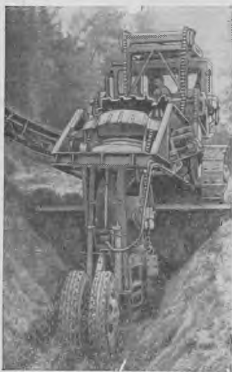
Экскаватор с ножами-откосниками в работе
