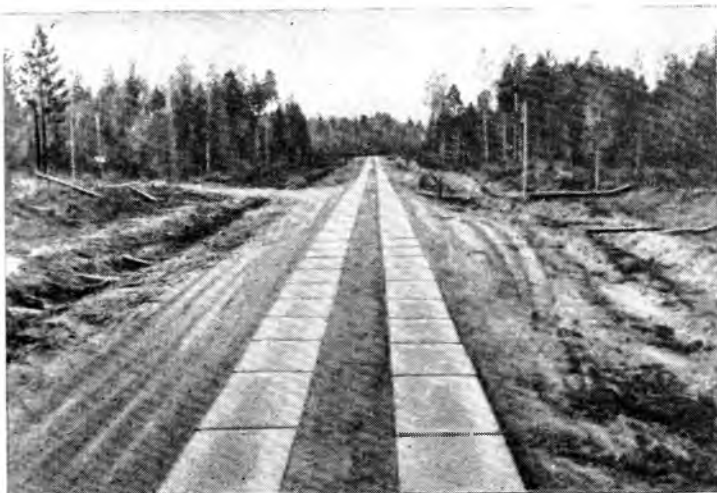
Рис. 1. Участок лесовозной автомобильной дороги, состоящий из ячеистых железобетонных плит.
