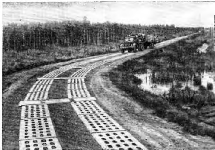
Рис. 2. Участок лесовозной автомобильной дороги, состоящий из решетчатых, железобетонных плит.
