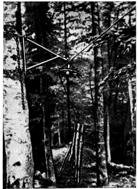
Укрепленная на дереве опора подвесной канатной дороги типа «Лассо-кабель».
