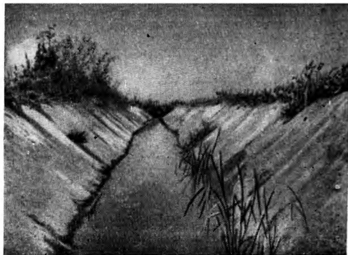
Рис. 4. Покрытие из грунтоцемента (Краснознаменская оросительная система)
