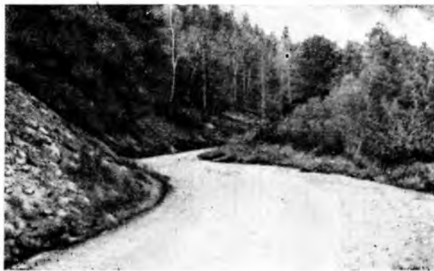
Рис. 17. Участок дороги со стабилизированным покрытием
