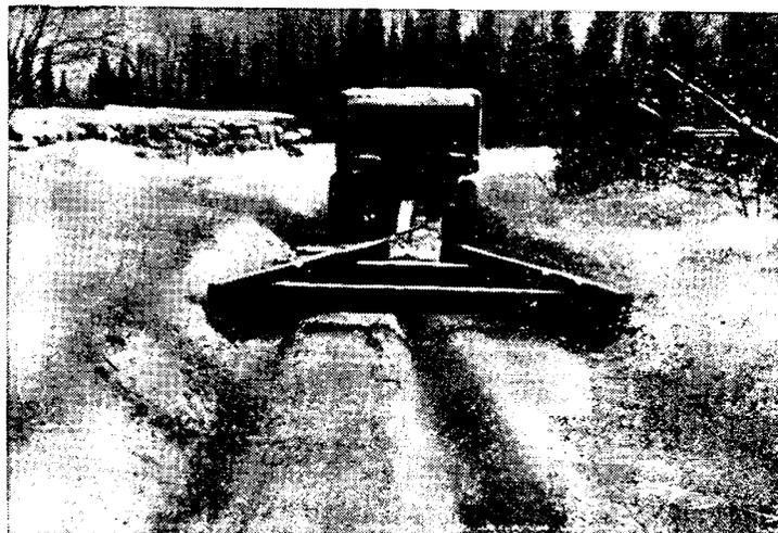
Рис. 1. Колеерез-снегоочиститель Штаркера в работе
