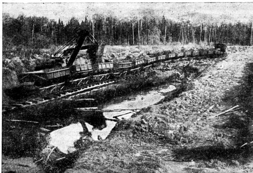
Рис. 3. Погрузка грунта в вагонетки Т-54.
