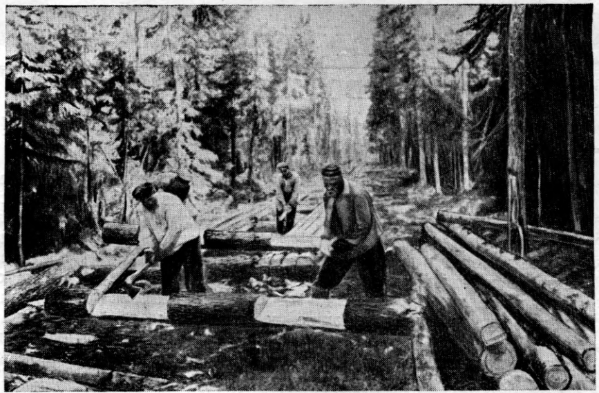
Рис. 6. На строительстве бревенчатой авто-лежневой дороги
