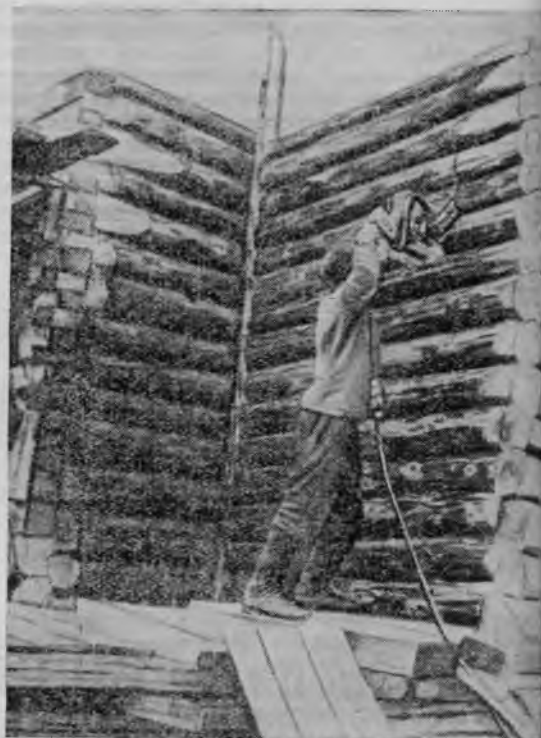
Рис. 2. Выпиливание дверного проема переоборудованной пилой ЦНИИМЭ-К5
