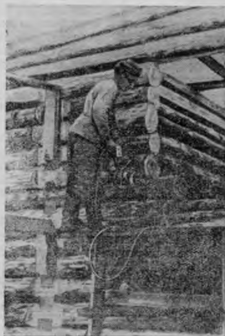
Рис. 3. Выпиливание оконного проема пилой ЦНИИМЭ-К5
