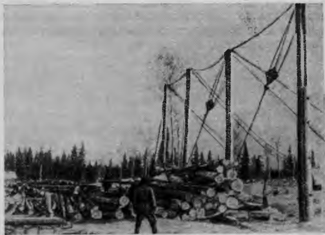
Рис. 5. Разгрузка хлыстов бревносвалами
