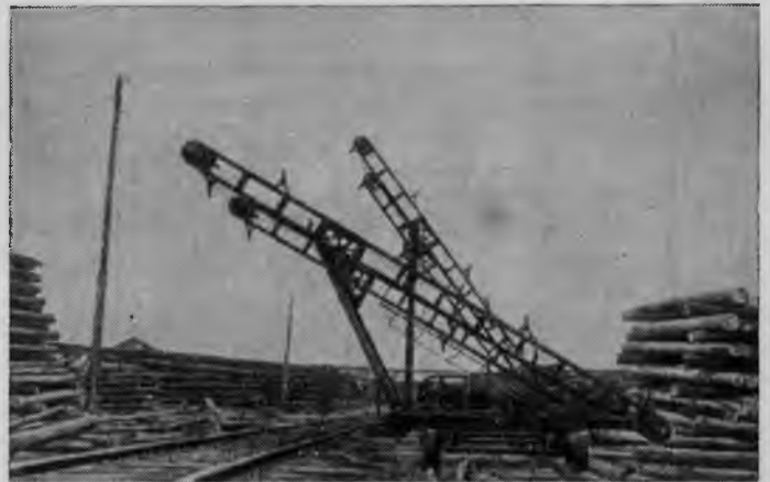
Рис. 2. Погрузатели с опущенными и вертикальными стойками
