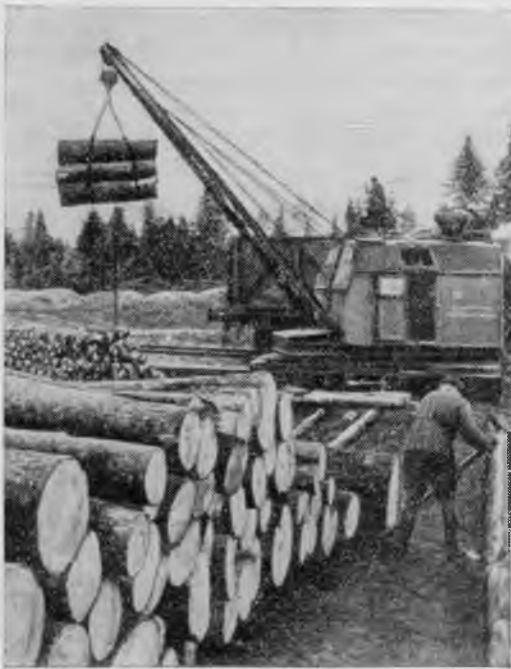
Рис. 9. Паровой кран грузит деловое коротье в вагон широкой колеи (фото А. К. Артемьева)
