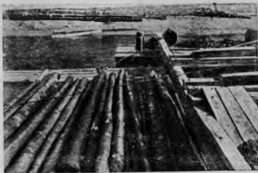
Рис. 4. Сжатие щети бревен в пучок (Обвинский рейд)
