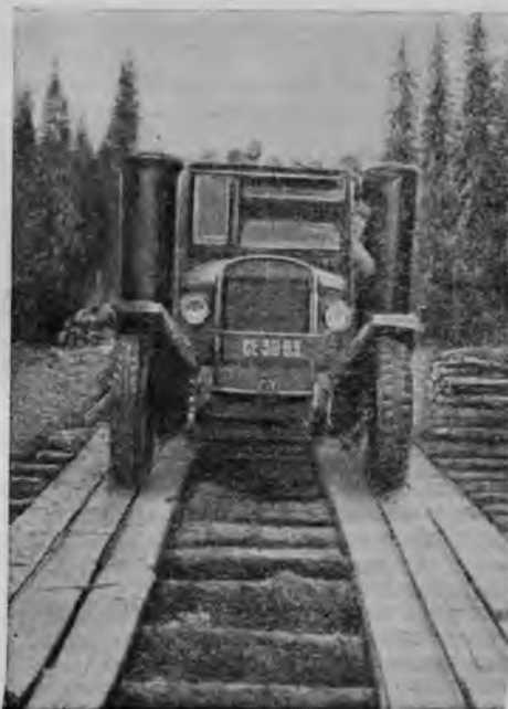
Рис. 2. Безбортовая авто-лежневая дорога (Ирбитский лесопромхоз треста Свердловск)
