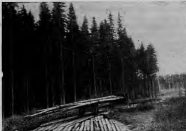
Рис. 3. Автомобиль, груженный хлыстами, на Курьинской безбортовой лежневой дороге (Ирбитский леспромхоз треста Свердловлес)
