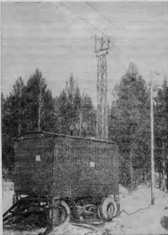
Рис. 1. Передвижная трансформаторная подстанция для питания током от промышленной сети
