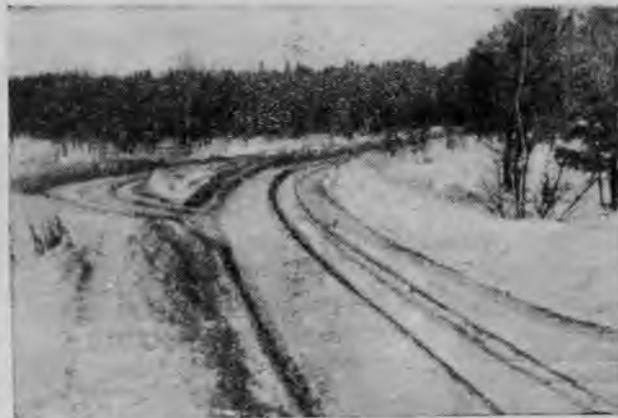
Рис. 3. Разъезд на одноколейной автомобильной снежно-ледяной дороге (Кордонская автомобильная дорога)
