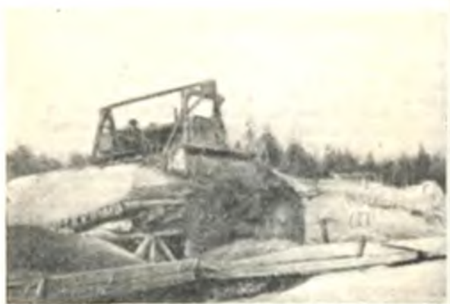
Рис. 2. Бульдозер сдвигает грунт на платформу
