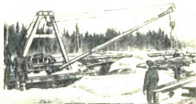
Рис. 3. Укладка звена в путь
