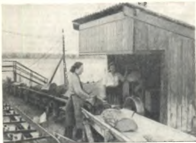
Рис. 6. Передача древесины с цепного на ленточный транспортер
