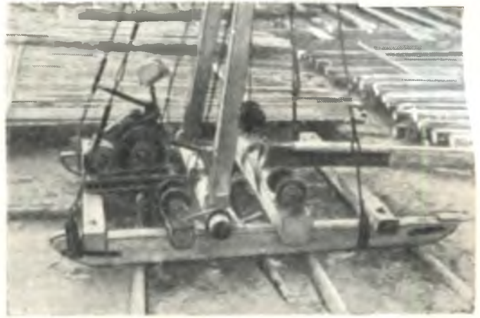
Рис. 2. Рама погрузочного устройства (поворотная стрела опущена)
