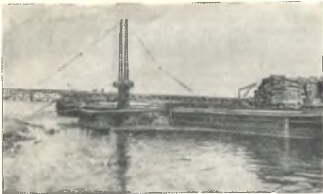
Рис. 5. Разгрузка баржи понтоном транспортером
