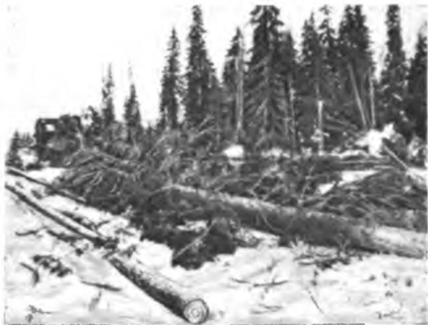
Рис. 2. Трелевка хлыстов с кроной вершиной вперед
