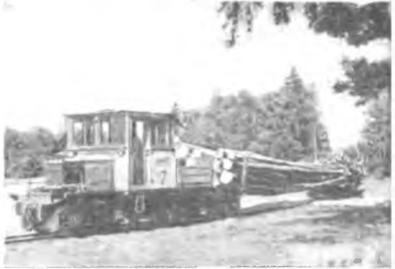
4. Вывозка леса в хлыстах мотовозом МУЗГ-4
