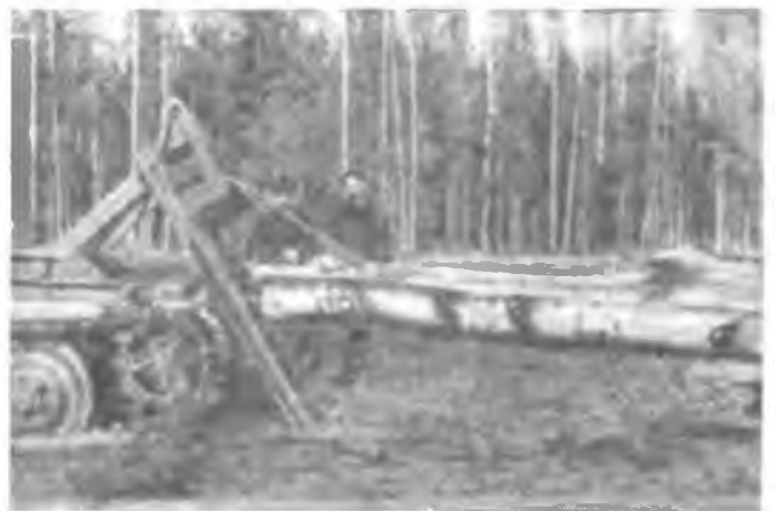
Рис. 3. Новое погрузочное устройство. Момент втаскивания пакета бревен на щит
