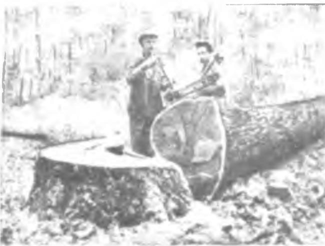
Рис. 1. Сваленный пилой ЦНИИМЭ-К5 дуб диаметром 105 см
