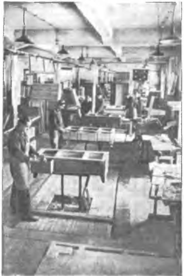
Рис. 1. Конвейер для сборки шкафов. Начало процесса сборки
