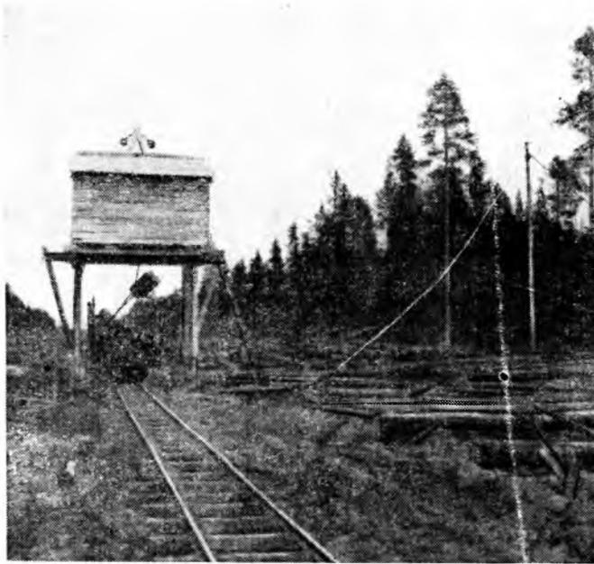
Рис. 2. Кран конструкции М. А. Завьялова на погрузке леса. Справа мачта для трелевки лебедкой
