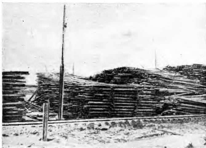
Рис. 5. Общий вид штабелей. Справа — штабели леса, выкатанного лебедкой, в центре — штабели леса, выкатанного обычным поперечным элеватором
