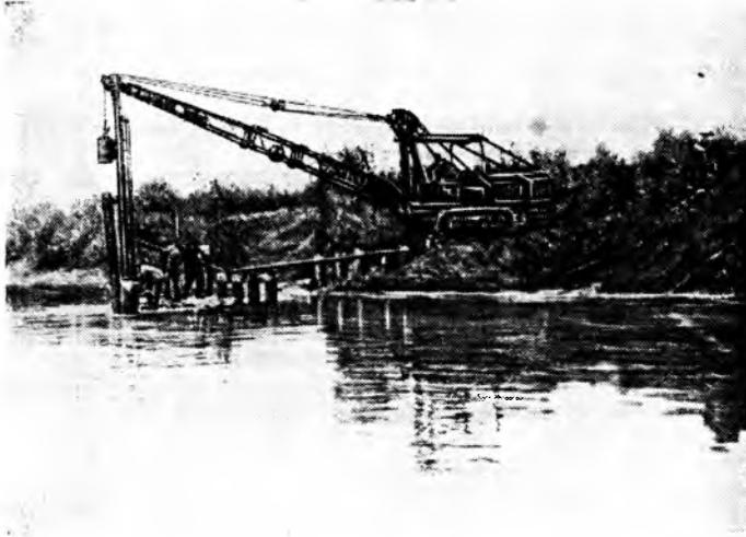
Рис. 3. СУТА-1 на забивке свай при строительстве моста
