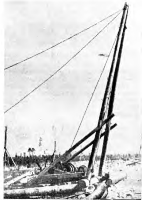
Рис. 2. Общий вид лебедки ТЛ-3 с погрузочной стрелой
