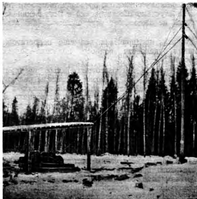
Рис. 2. Лебедка ТЛ-3 и мачта, оснащенные для полувоздушной трелевки
