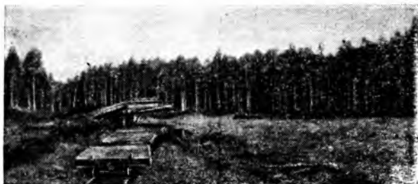
Бункерная эстакада для погрузки балласта бульдозером
