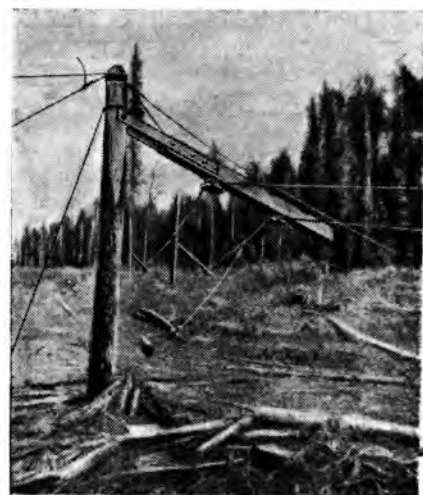
Рис. 2. Поворотная блочная батарея в работе
