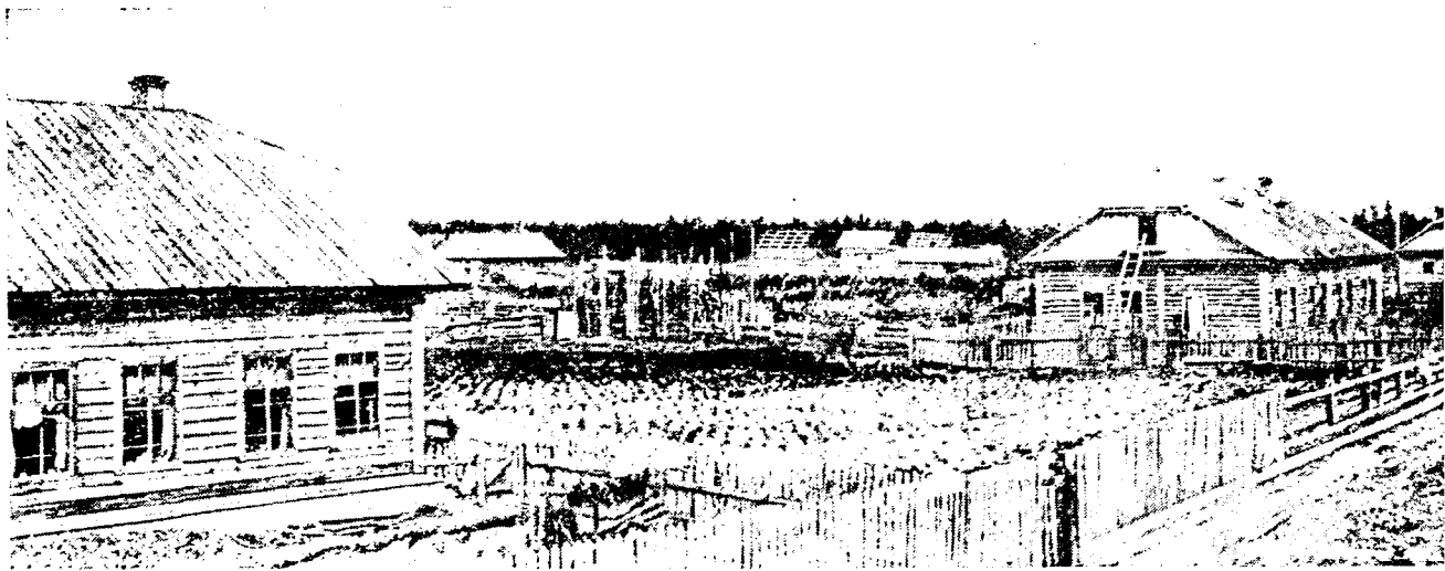
Быстро растет рабочий поселок Тюлькинскогo рейда на Каме. Недавно закончено строительство 14 домов и начата постройка электростанции и средней школы. На снимке: рабочий поселок сплавщиков.
