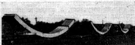
Рис. 3. Перевозка клееных гнутых арок по железной дороге
