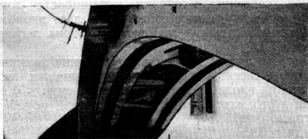
Рис. 2. Мост из гнутых клееных балок: А—общий вид; Б—вид балок внизу
