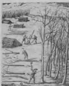
5. Бригадный метод лесозаготовок по Дюкамелю де-Монсо в середине XVIII в. во Франции. Наряду с разделением труда особое значение имела в это время специализация ин-струмента
