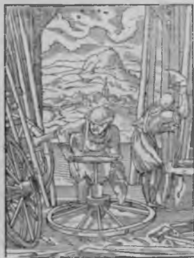
5. Производство спицажных колес. Мастер работает с учеником.
