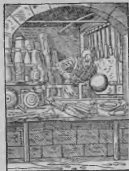
3. Обточка (XVI в., Германия) на станке альтернативного типа
