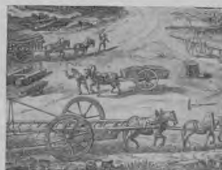
6. Способы транспортировки лесных полуфабрикатов конной тягой, предложенные Дюкамелем де-Монсо и получившие во второй половине XVIII в. широкое распространение во всей Западной Европе
