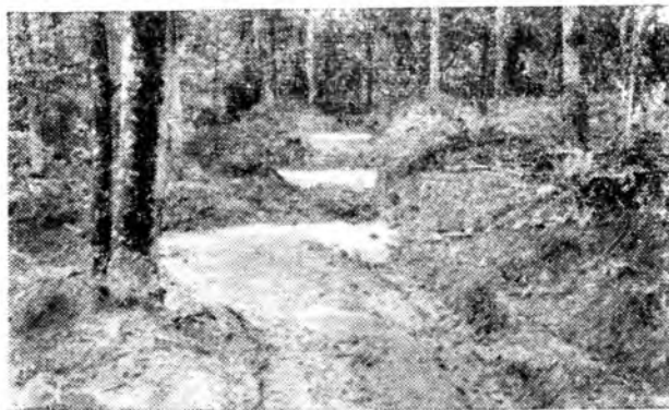
Рис. 3. Размытый волок и закрепленный валами
