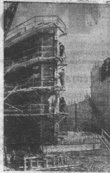
На строительстве Новосибирской ГЭС наступили решающие дни. Нынешняя весна будет с е р ь ё з н ы м испытанием для строителей первой гидроэлектростанции на Оби. Великая сибирская река впервые встретит на своём пути преграду и огромной массой льда и воды обрушится на водонапорный фронт станции, который состоит из пятикилометровой земляной плотины, бетонной волосливной плотины и здания ГЭС. Коллектив стройки, включившись в специализированное соревнование за достойную встречу 40-й годовщины Великого Октября, готовится во всеоружии встретить вешние воды Оби. Строители ГЭС обязались подготовить к 1 мая судоходные устройства к пропуску судов, в четвертом квартале закончить монтаж двух первых агрегатов станции и дать ток окрестным
