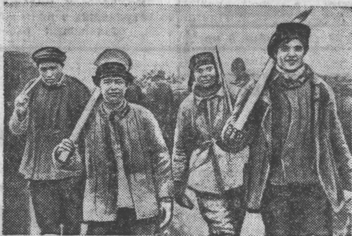
Комсомольская бригада бетонщиков на Днепрострое
