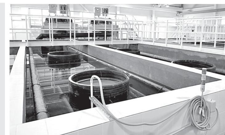
Еще один масштабный проект, реализованный в Шексне, - реконструкция очистных сооружений. В поселке перешли на двухступенчатую схему очистки воды. Решение о реконструкции было принято на Градсовете. «Водопроводные очистные сооружения были построены 40 лет назад. Одноступенчатая система не обеспечивала нужного качества воды. Мы начали реконструкцию по региональной программе «Вода Вологодчины». Сейчас все жители Шексны
