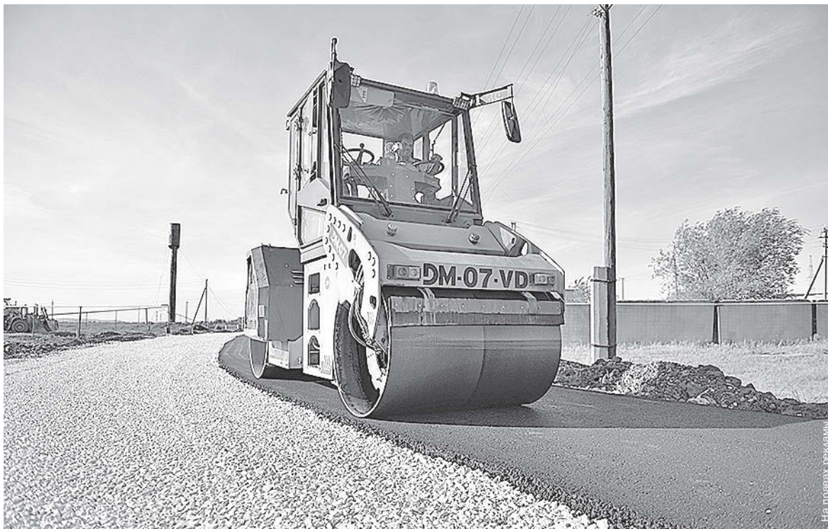
Дороги, построенные с использованием фосфогипса, могут эксплуатироваться без ремонта до 12 лет.
