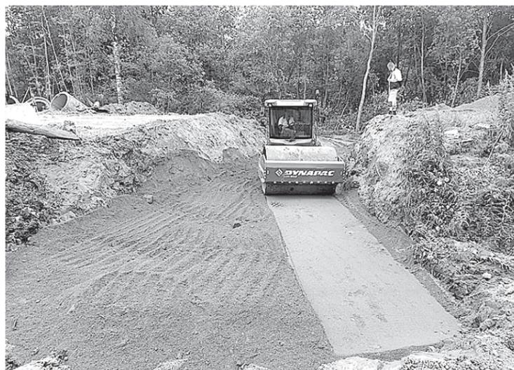
Сейчас на трассе Вохтога - Грязовец ведется восстановление водопропускных труб и подготовка к проведению ремонта покрытия проезжей части.
