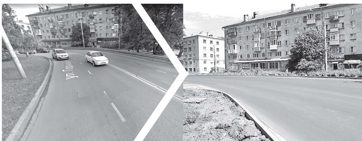
В 2020 году расширен опасный поворот на улице Горького. Работы завершились на днях (на фото справа).
