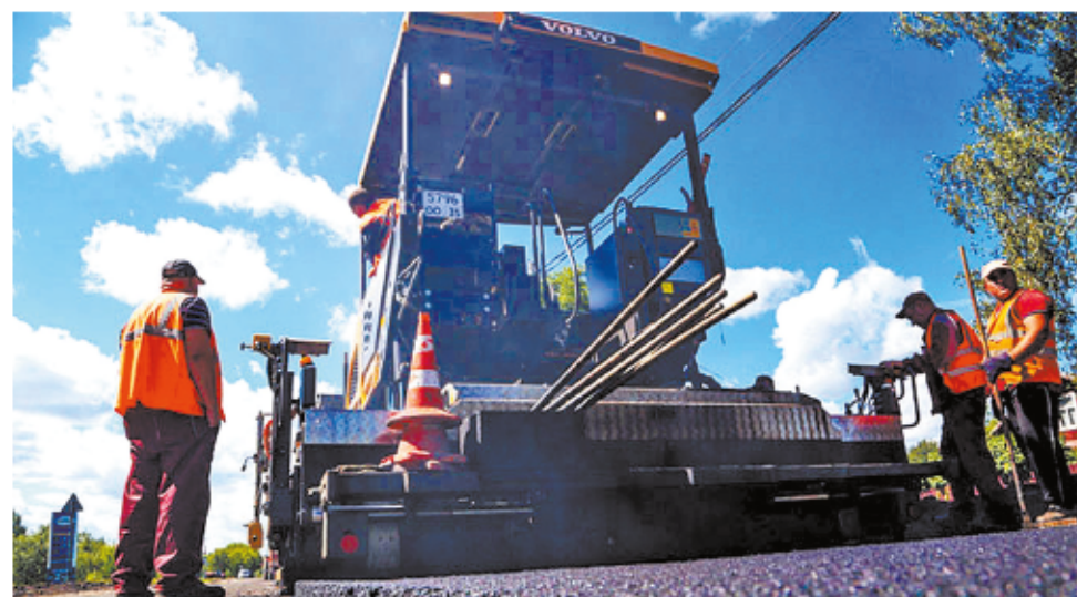
На сегодняшний день подрядчики завершили фрезерование проезжей части, выложили из щебня основание, укладывают выравнивающий слой. | Фото с сайта vologdaregion.ru
