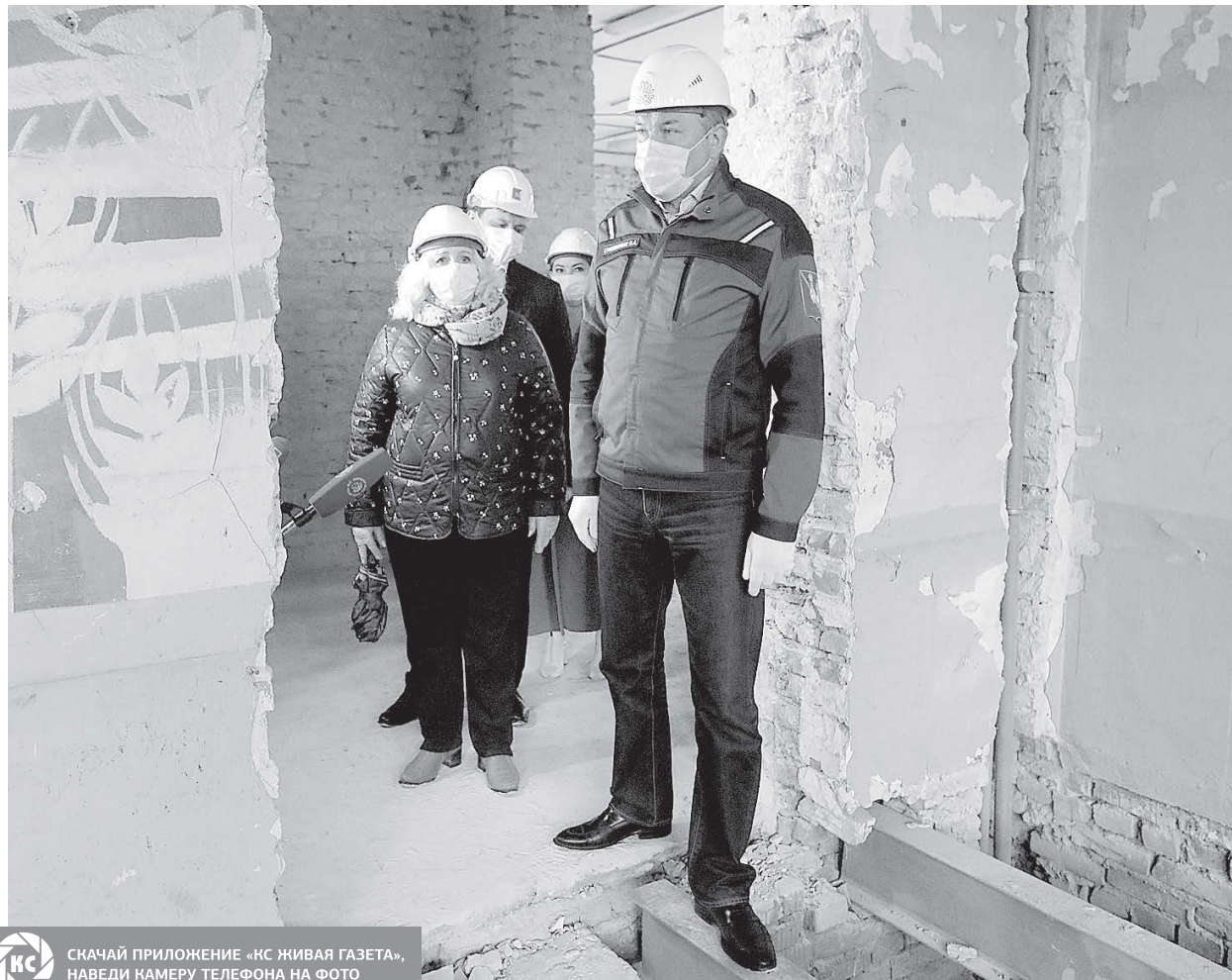
Губернатор Олег Кувшинников остался доволен темпами капитального ремонта школы № 11 в областном центре. | Фото пресс-службы губернатора
