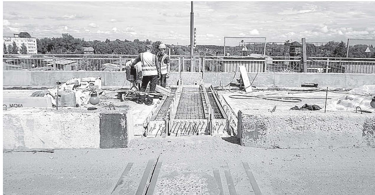
Капитальный ремонт путепровода в Соколе. Производится обустройство гидроизоляции, ремонт деформационных швов, ремонт тротуара и дренажных каналов. Начинается ремонт сходов и опор. | Фото пресс-службы правительства области
