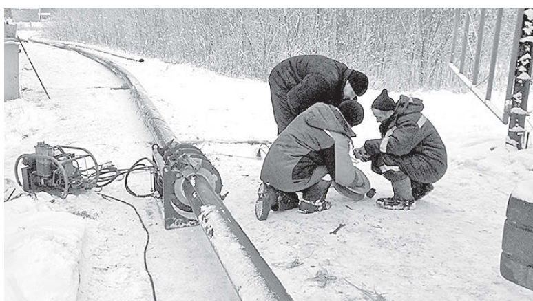
Весь комплекс работ должен быть завершен до апреля 2019 года.
