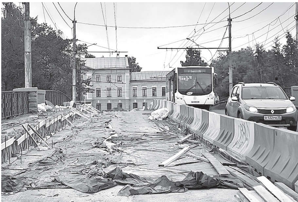
В ближайшее время строители займутся асфальтированием второй части моста.
