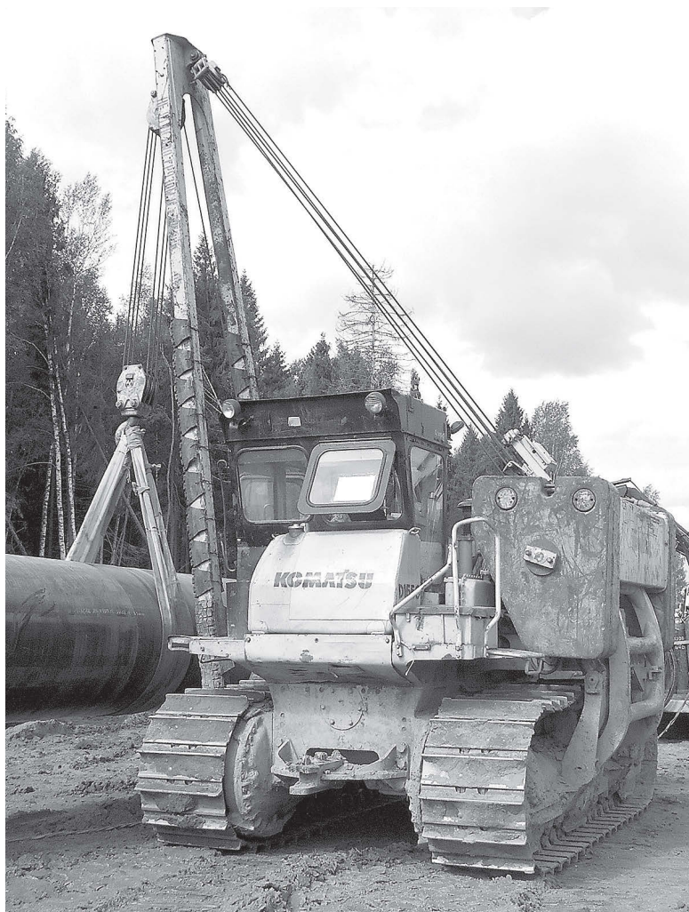
Газопровод, строящийся на территории Шекснинского района.
