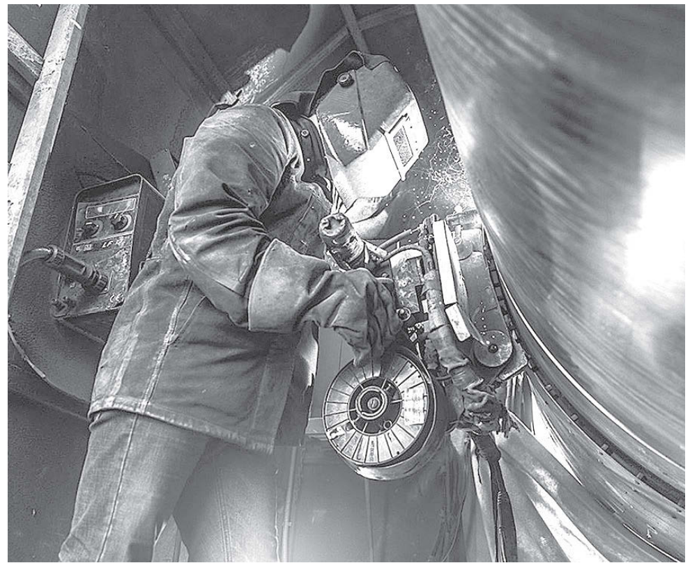
Сварка труб большого диаметра осуществляется в автоматическом режиме, но управляет всем процессом сварщик-оператор.
