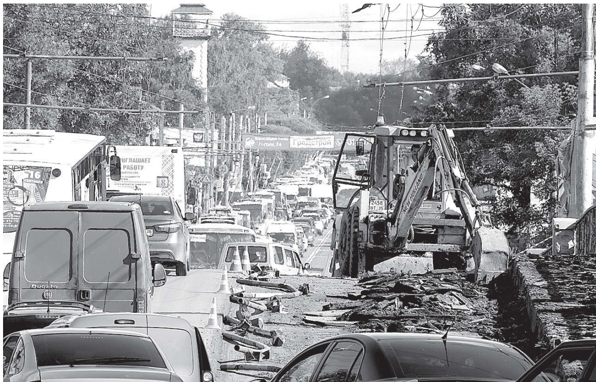
Ремонт Октябрьского моста продлится два месяца. | Фото Валентины Певцовой
